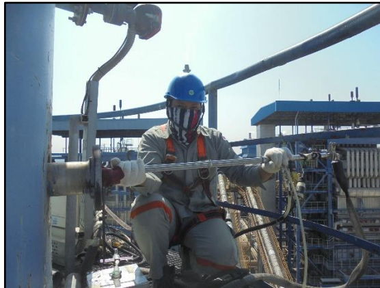
ภาพที่ 3.12 การตรวจวัดฝุ่นละออง (TSP) และก๊าซซัลเฟอร์ไดออกไซด์ ( \text{SO}_2 ) บริเวณปล่องระบายจากหม้อไอน้ำ
